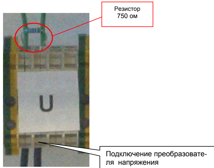
Рис. 5-1 Подключение клемм преобразователя напряжения
