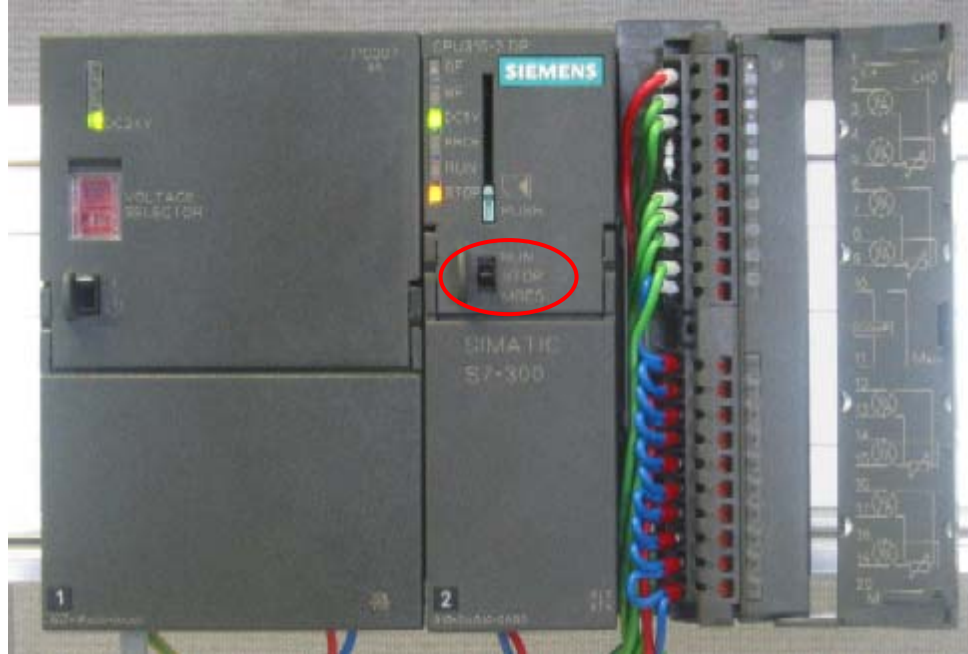
Рисунок 5-1 Проверка монтажа, CPU в режиме STOP
